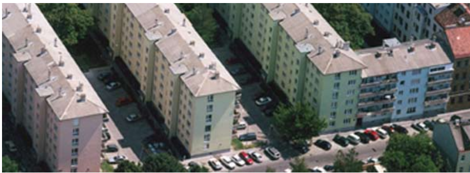
Pionierprojekt der Thewosan-Sanierung in der Sinagasse. 15 Stiegen eingepackt mit Vollwärmeschutz
