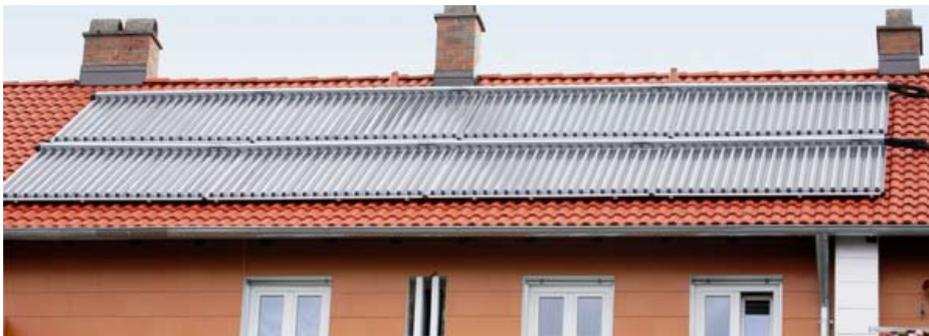
Neue Hochleistungs-Vakuumpipelinekollektoren unterstützen die Heizung und die Warmwasserbereitung.
