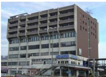
Vor allem bei den 4 600 Quadratmetern Fassadenfläche, hiervon rund 2 000 Quadratmeter Beton-Untergrund, gab es erheblichen Sanierungsbedarf. Dieser wurde in einem Gutachten der FMPA Stuttgart festgestellt, das die hierfür entstehenden Kosten auf rund 700 000 Euro schätzte. Die Eigentümerversammlung beschloss, diesen Betrag zu investieren. Sie beauftragte nach einem Vorschlag der Treubau Verwaltungs GmbH das Ingenieurbüro Zimbelmann
