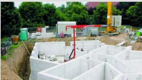
den aufgehenden Wänden über die Fundamente in den Baugrund ab. Bei den Kelleraußenwänden ergibt sich zusätzlich eine horizontale Belastung durch die Erdanschüttung. Die daraus resultierende Biegebeanspruchung kann bei vertikaler Belastung relativ leicht aufgenommen werden. In diesem Fall können die KS-Kelleraußenwände auch bei hohen Erdanschüttungen mit Wanddicken  $\geq 24$  cm sehr schlank ausgeführt werden. ([www.kalksandstein.de](http://www.kalksandstein.de))
