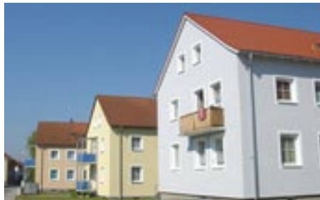
Häuser aus den 50ziger und 60ziger Jahren wurden modernisiert.
