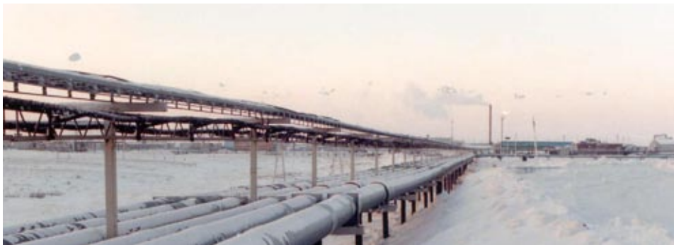
Pipelines mit Gasverarbeitungsanlage im Hintergrund im ewigen Frost. Foto: eon-ruhrgas
