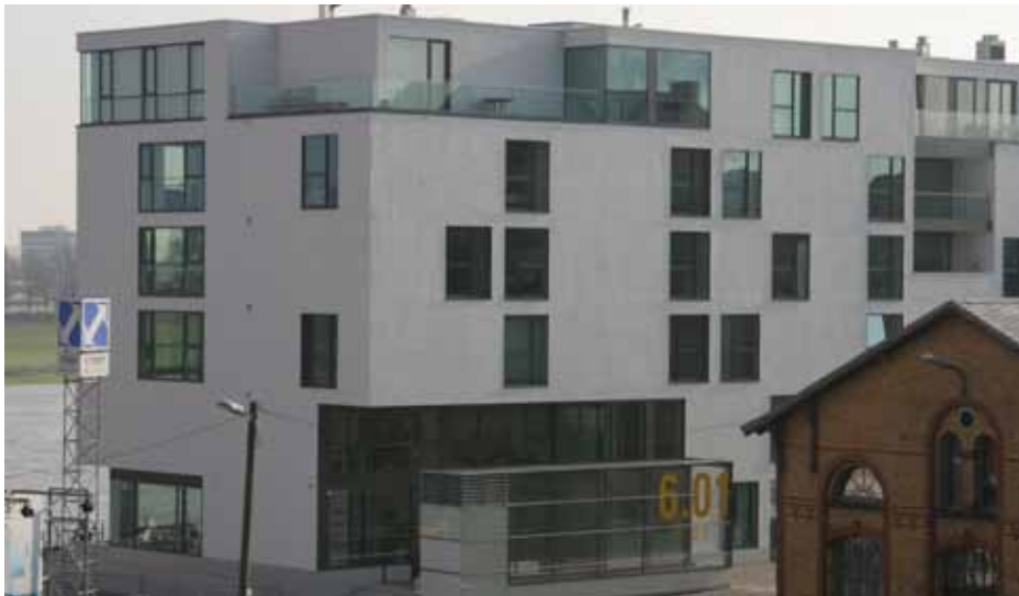
Wohnungen zur Stadt- und an den Kopfseiten der Wohnwer[f]t geschlossen
