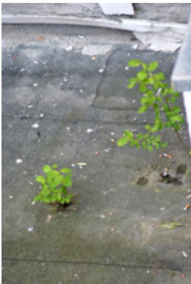
Dachflächen mit einer Dachneigung unter 2 % sind Sonderkonstruktionen und erfordern besondere Maßnahmen, um Schadensbildung durch stehendes Wasser zu vermeiden.
