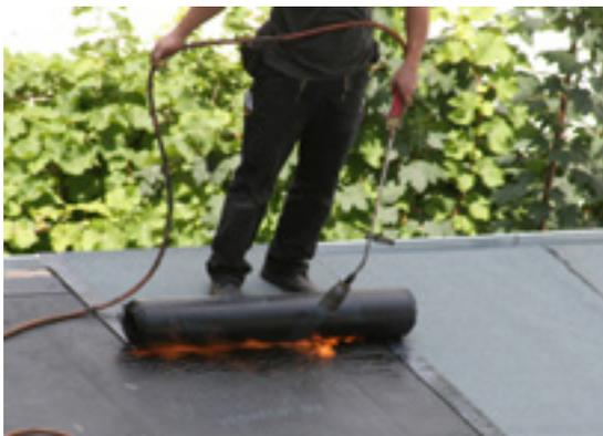
Dächer werden häufig mit Bitumen- und Polymerbitumenbahnen eingedeckt. Dachabdichtungen mit Bitumenbahnen sollten neu mehrlagig, bei Reparaturen oder Sanierungen i. d. R. einlagig, ausgeführt werden. Als Oberlage werden Polymerbitumenbahnen, z. B. mit Splittbestreuung oder (bei einem Kiespressdach) nackt, verwendet. In aller Regel werden genormte Dachbahnen verarbeitet (lt. Aufdruck auf der Verpackung).
