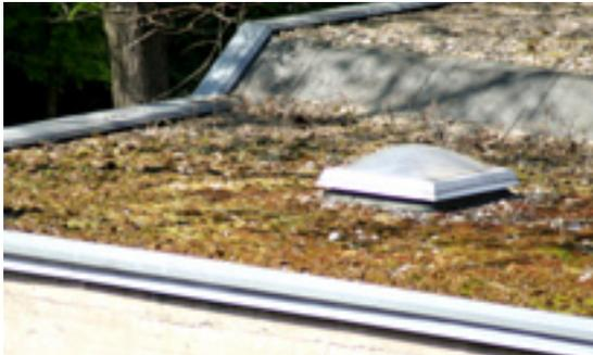
Die Sicherung von Dachabdichtungen und deren Schichtaufbau gegen Abheben durch Windlast kann durch Auflast, Verklebung und/oder mechanische Befestigung erfolgen. Zur Festlegung der Windlasten ist in Deutschland DIN 1055 Teil 4 zu berücksichtigen. Dabei ist für die Dachabdichtung ein Sicherheitsfaktor einzurechnen.
