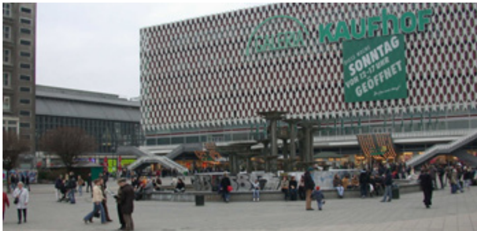
Berlin Alexanderplatz alte Alufassade
