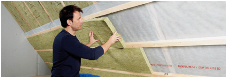
Der Dachraum wird luftdicht verpackt. Foto Rockwool
