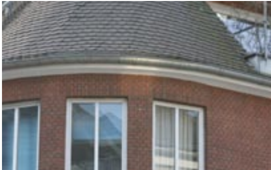
Konstruktiv gelungener Anschluss einer halbrunden verzinkten Metalldachrinne an einem Kegeldach
