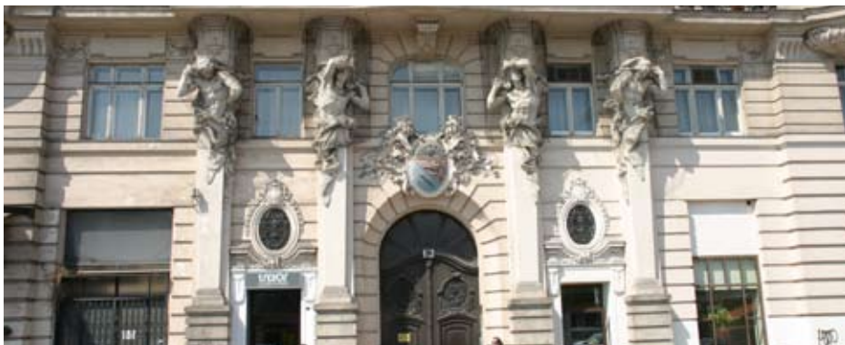
Gesäuberte Barockfassade nach Instandhaltung, ehemaliges Palais in Wien; alle Fotos hier Krolkiewicz
