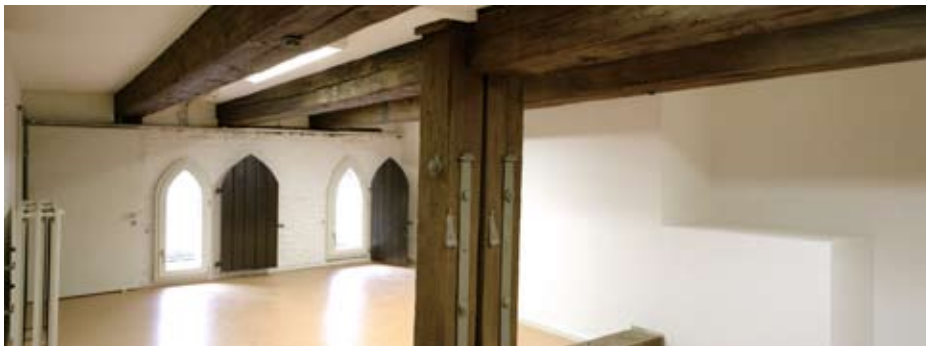
In Trockenbautechnik sanierter Sitzungsraum mit sichtbaren Deckenbalken Foto: Rigips
