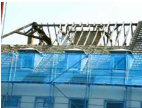
Häufig werden vom Handwerker zwei sehr wichtige Verarbeitungspunkte vergessen: Die Windsogsicherung und der richtige Blitzschutz. Eine Windsogsicherung muss nicht nur gemäß den Normen und Dachdeckerrichtlinien sachgemäß ausgeführt werden, das verarbeitete Bauteil muss auch in Form und Material vom Dachbaustoffhersteller für sein Produkt zugelassen werden. Hierfür gibt es im Internet eine hilfreiche Adresse: [www.fos.de](http://www.fos.de). Dort finden sie für
