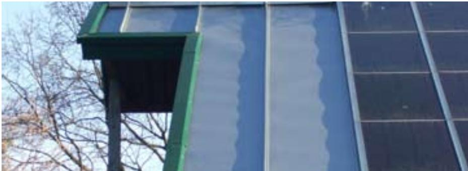
Gebürsteter Edelstahl statt Ziegel, wärmedämmend und mit Photovoltaikanlage, eine nachhaltige Investition zur Gebäudewerterhaltung.
