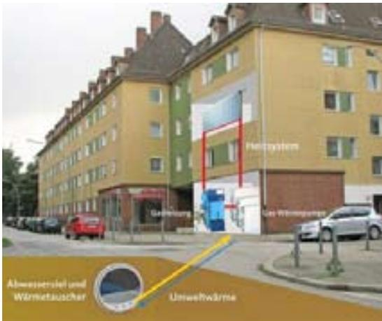
zung von Wohnungen Wärme aus Abwasser gewonnen. Die Anlage, an die in diesem Jahr 110 Wohneinheiten und 2010 weitere 100 Wohnungen angeschlossen werden, ist die größte ihrer Art in Deutschland. Zum Einsatz kommen ein 50 Meter langer Wärmetauscher und zwei Gas-Absorptionspumpen. Ergebnis: Die CO<sub>2</sub>-Emissionen sinken um 75 Prozent. Das Investitionsvolumen für das in Kooperation mit Hamburg Wasser realisierte vorbildliche Projekt beträgt 1,8 Millionen Euro.
