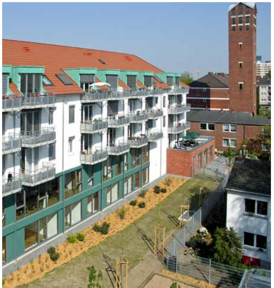
NEUBAU ZOLLSTOCKGÜRTEL 33-33c RÜCKSEITE
