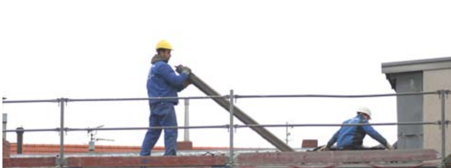
Abbruch Asbestzement-Wellplatten
