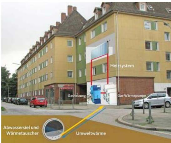
zung von Wohnungen Wärme aus Abwasser gewonnen. Die Anlage, an die in diesem Jahr 110 Wohneinheiten und 2010 weitere 100 Wohnungen angeschlossen werden, ist die größte ihrer Art in Deutschland. Zum Einsatz kommen ein 50 Meter langer Wärmetauscher und zwei Gas-Absorptionspumpen. Ergebnis: Die CO<sub>2</sub>-Emissionen sinken um 75 Prozent. Das Investitionsvolumen für das in Kooperation mit Hamburg Wasser realisierte vorbildliche Projekt beträgt 1,8 Millionen Euro.
