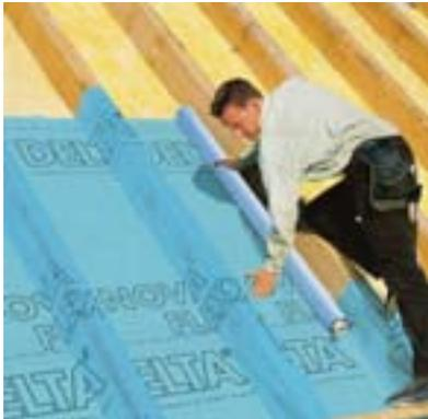
tungstechnisch lässt sich eine außen angeordnete Winddichtung einfacher einbauen als die innen liegende Luftdichtheitsebene. Die Winddichtigkeit ist bisher nicht genormt und deshalb keine grundsätzliche Forderung, sie verringert die Luftströmung von außen nach innen.
