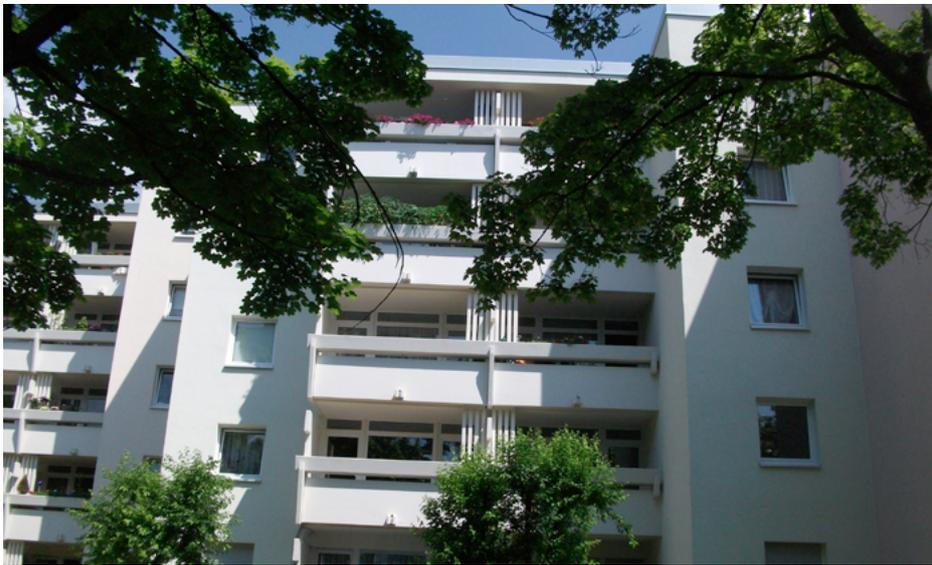
Fassadenversprünge und geringe Anschlusshöhen der Balkontüren stellen erhöhte Anforderungen an das Abdichtungssystem; alle Fotos Triflex
