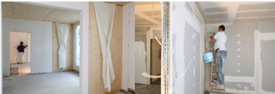
Holzdecke und Gipskartonwand
