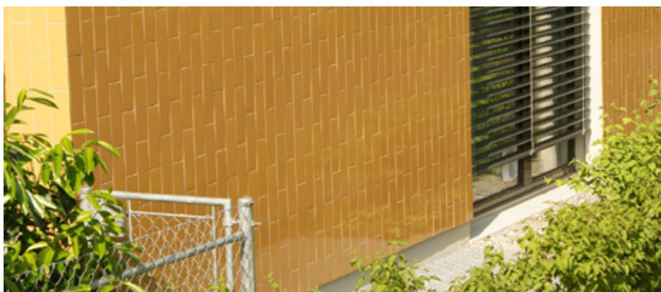
Ansetzen Dämmplatte, Foto Knauf
