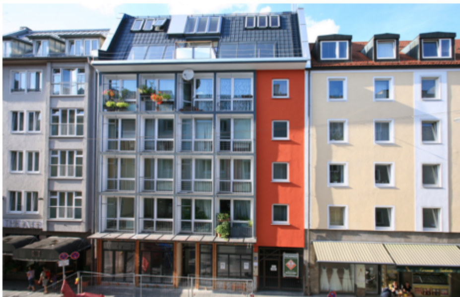
Sanierung in neuer Dimension
