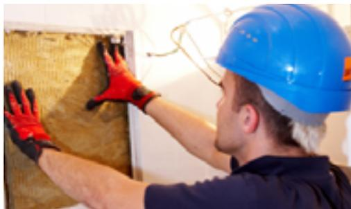
Mit Steinwolleflocken in einer Rohdichte von ca. 100 Kilogramm pro Kubikmeter befüllt, erreichen die Schächte I 90-Brandschutzqualität. Um bei einem erneuten Öffnen der Revisionsklappen das Ausflocken des Granulats zu vermeiden, setzen die Einblassezialisten von svt einfach eine passend zugeschnittene 20 mm starke Steinwolleplatte vor die Öffnung
