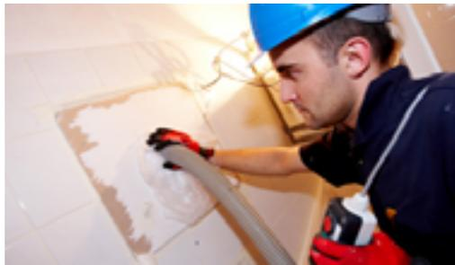
Mit wenigen Handgriffen konnten die Revisionsklappen in den Badezimmern freigelegt, geöffnet und als Einblasöffnung genutzt werden
