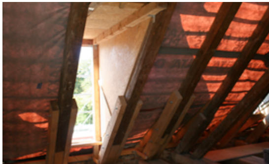
Dachsanierung Unterspannbahn
