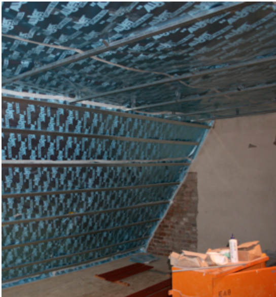
Dachgeschossausbau luftdicht
