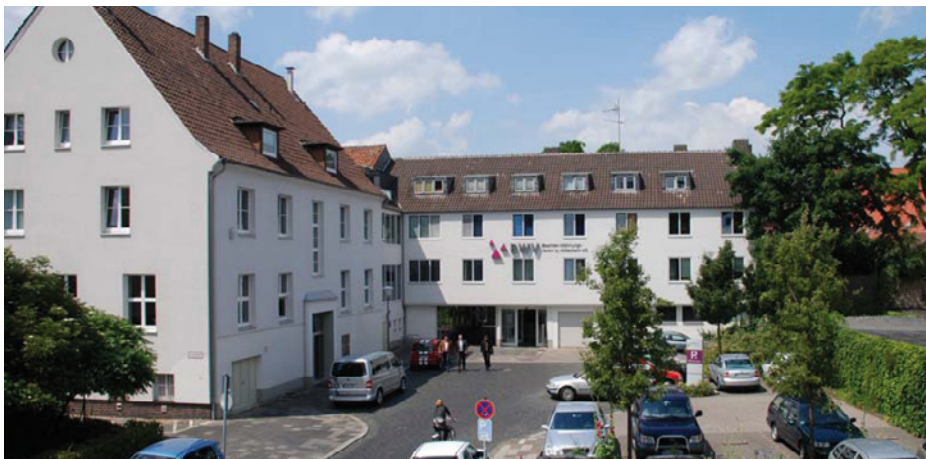
Verwaltungsgebäude Theaterstraße 7/8, Hildesheim
