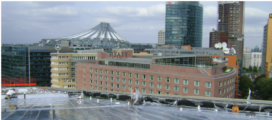
Die Staatsbibliothek Berlin mit der Metaldacheindeckung. Im Hintergrund die Gebäude des Potsdamer Platzes
