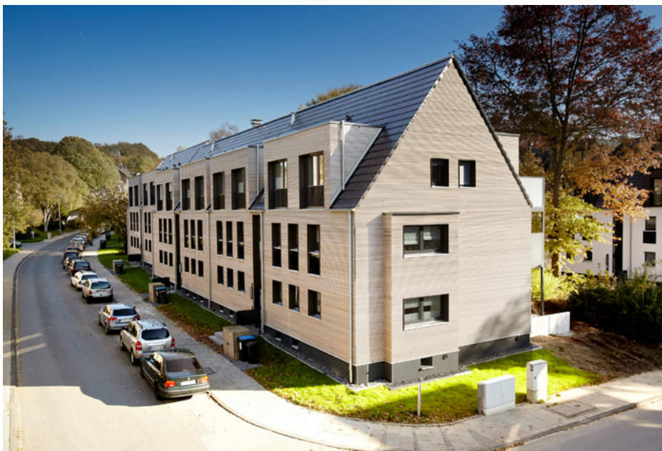
Fertiggestellte Wohnhäuser; alle Fotos Rockwool
