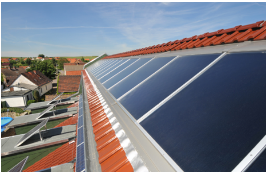
Ziegeldach mit PV-Anlage
