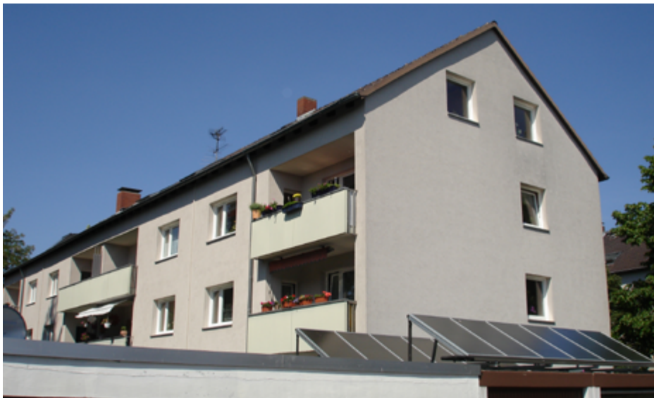
Fallbeispiel MFH mit 16 Wohneinheiten mit 16 m 2 Kollektor; alle Fotos Solvis
