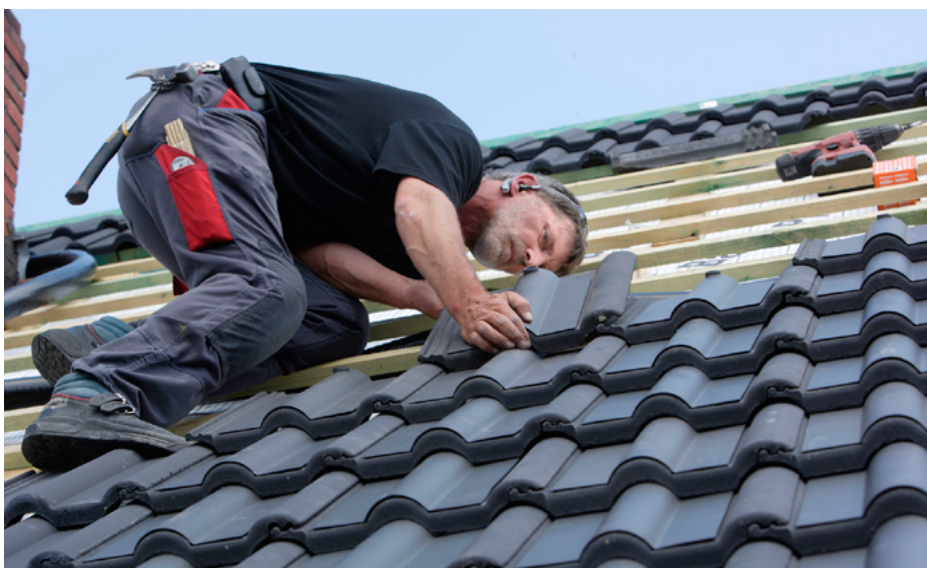
Verlegung Dachziegel; Foto Nelskamp
