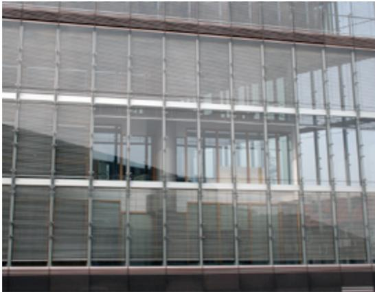
fassaden eine ganze Reihe weiterer Funktionen. Sie bieten Wärme-, Sonnen-, und Schallschutz, sorgen für ausreichende Frischluftzufuhr, lenken das Tageslicht in die Tiefe der Räume und produzieren zudem elektrischen Strom. Richtig eingesetzt, werden Glasfassaden zu Licht spendenden und Energie gewinnenden Hüllen, die sich den variierenden Umgebungsbedingungen anpassen und so nachhaltig zur Schonung der Umweltressourcen beitragen.
