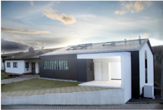
Während die Giebelseite und der mit einem winkelförmigen Vordach markant ausgebildete Eingangsbereich strahlend weiß verputzt sind, wurden die Längsseiten mit anthrazit durchgefärbten Faserzementtafeln bekleidet. Die vorgehängte hinterlüftete Fassadekonstruktion schließt direkt an die Dachhaut aus flachen Eternit Dachsteinen an – ohne Dachüberstand und sichtbare Dachrinne.
