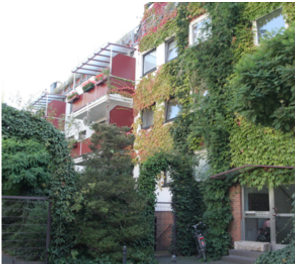
Nachhaltige Fassadenbegrünung Köln
