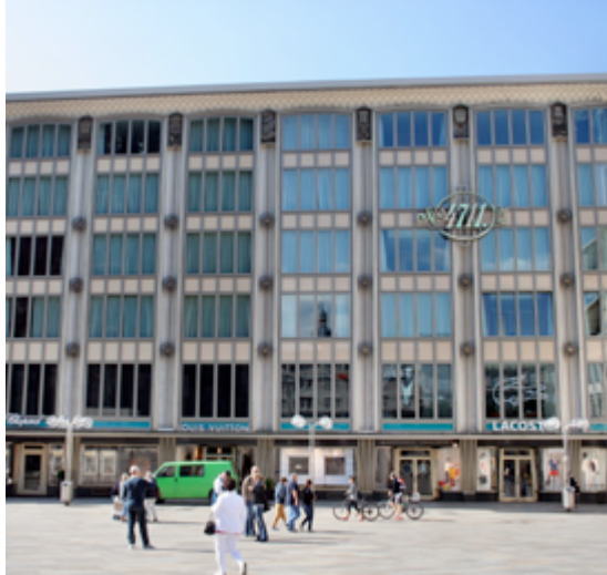
Blau-Gold-Haus Köln, Fassadensanierung
