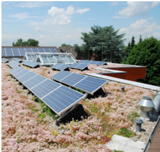
Dachbegrünung mit Photovoltaik
