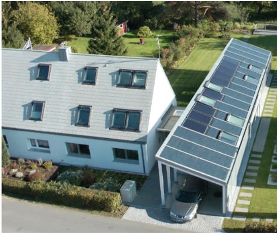
Aufgrund des Anteils von 33 Prozent (im Verhältnis zur Wohnfläche) Fensterfläche, sind für die Raumausleuchtung weniger elektrische Beleuchtungskörper notwendig. In Verbindung mit modernen Leuchtkörpern, beispielsweise Leuchtdioden, lässt sich intensiv teurer Strom sparen. Bei der Be- und Entlüftung des Hauses übernehmen die Dachflächenfenster eine wichtige Rolle. Aufgrund energetischer Vorschriften ist das Haus luftdicht ausgeführt. Diese Luftdichtigkeit führt, besonders
