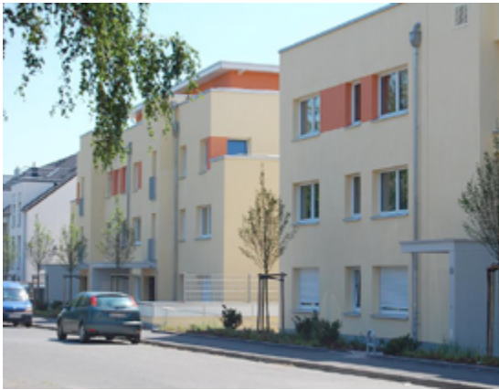
Die Klimaschutzsiedlung an der Teutonenstraße in Bonn – Bad Godesberg
