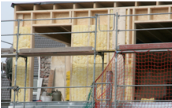
Holzunterkonstruktion; Foto Krolkiewicz
