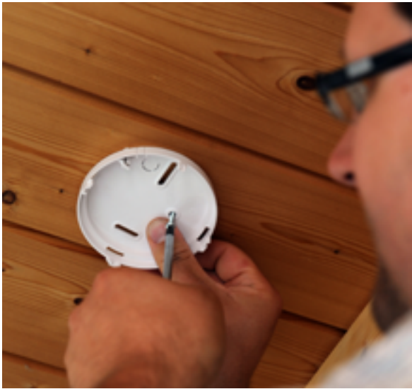
Schnell, sauber, lärmfrei – Klebmontage eines Rauchwarnmelder
