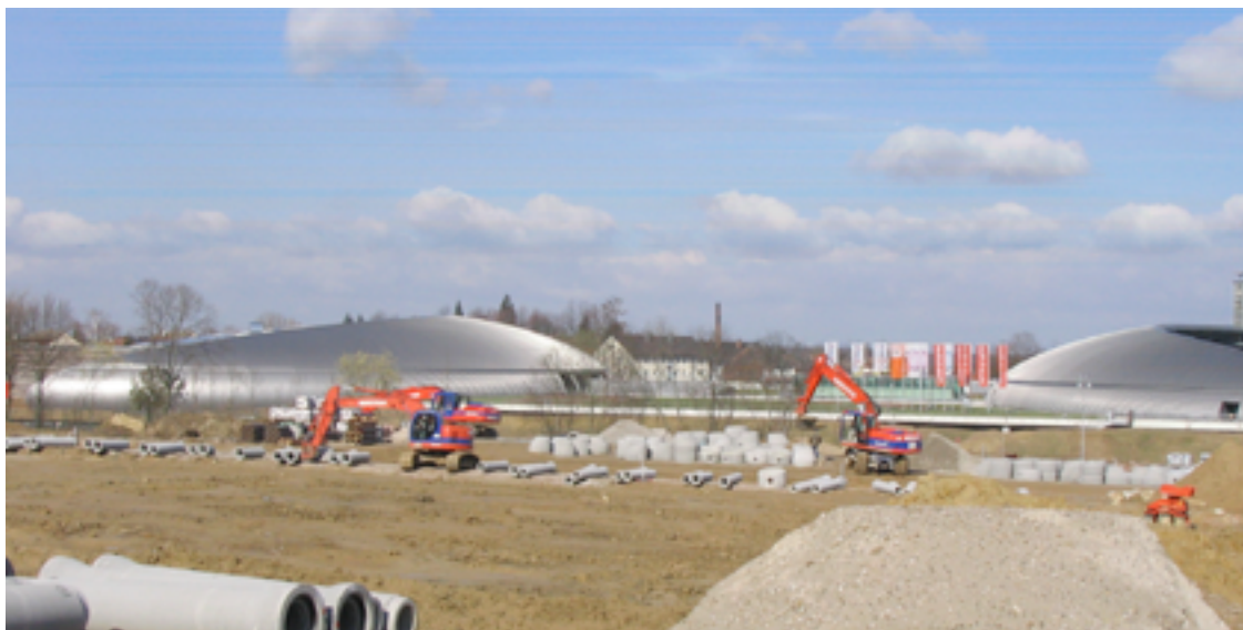
Geländeerschließung; alle Bilder RIB
