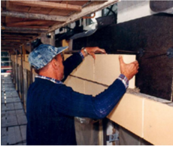
Vormauerschale Luftschicht; Foto Krolkiewicz
