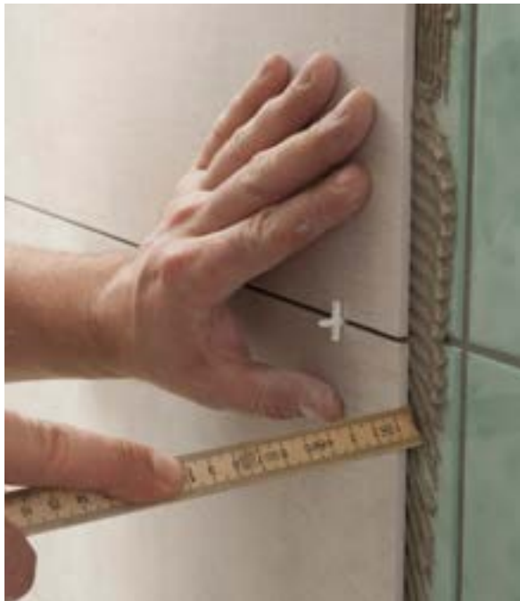
Verlegung auf alten Fliesen
