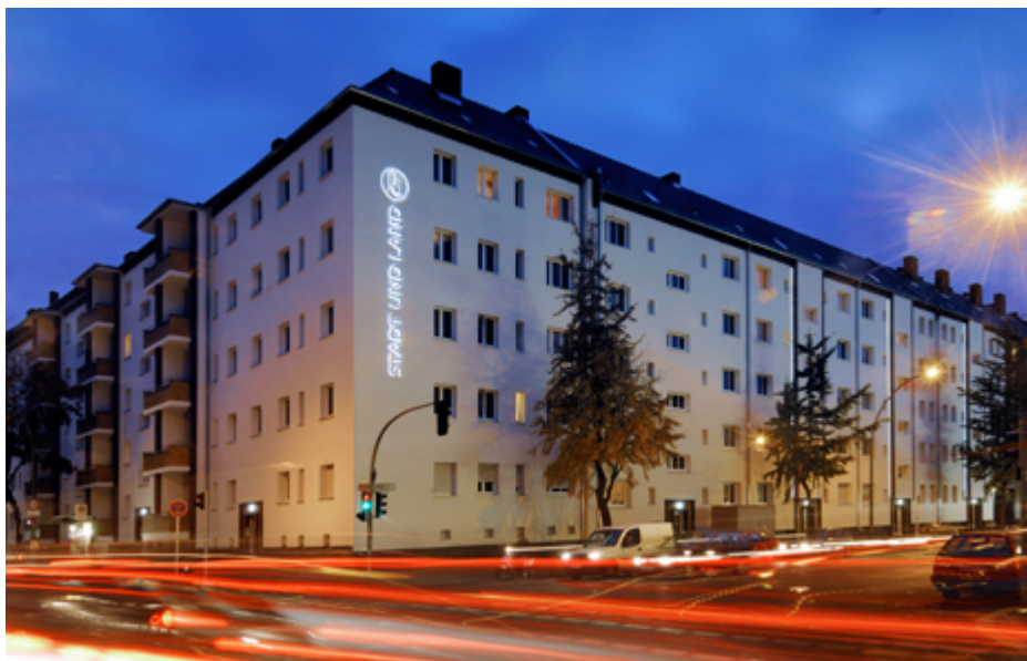
Sanierungsmaßnahme durch die STADT UND LAND Wohnbauten-Gesellschaft mbH. Sanierungsmaßnahme Dudenstraße Ecke Boelckestraße. Ausschreibungs- und Vergabeprozesse mit Zukunftspotenzial; alle Fotos rib
