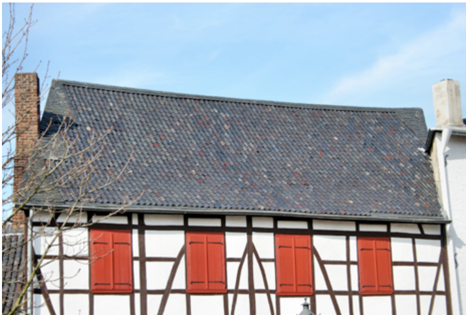
Denkmalgeschützte Dachsanierung; alle Fotos Krolkiewicz
