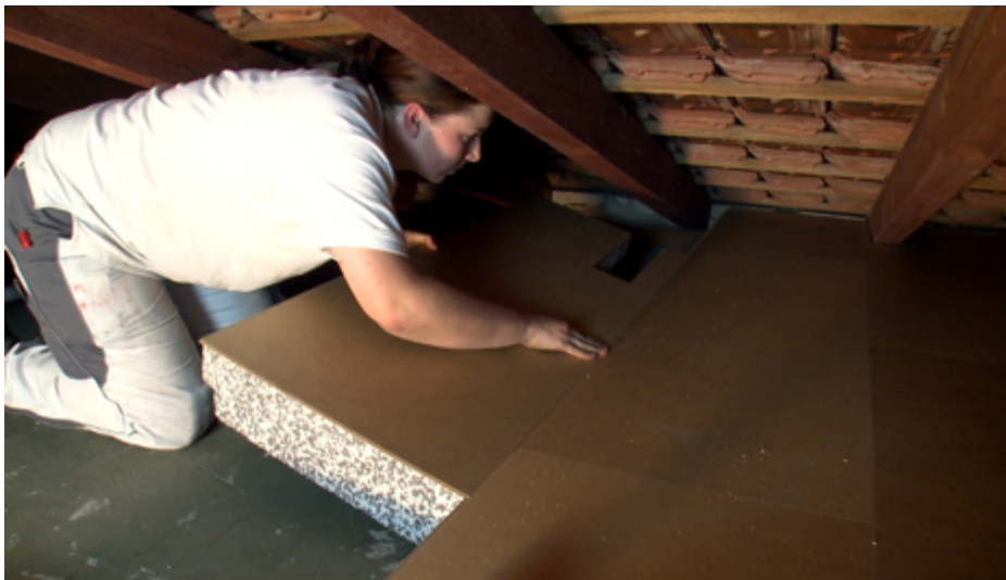
halb rationelles Verlegen von CapaClick-Speicherbodenelementen; alle Fotos Caparol
