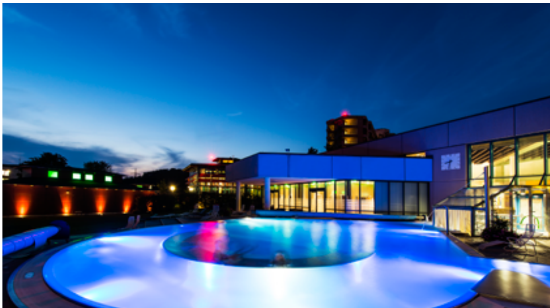
Außenbereich Aqualon; alle Fotos Knauf Aquapanel
