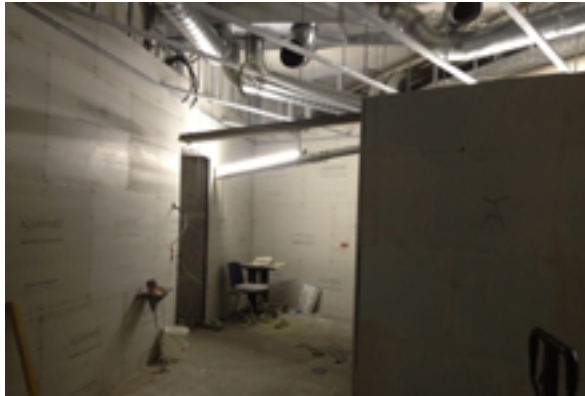
Trockenbau Nassbereich Aqualon
