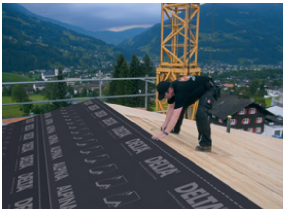
Bahnenverlegung (Dörken)
