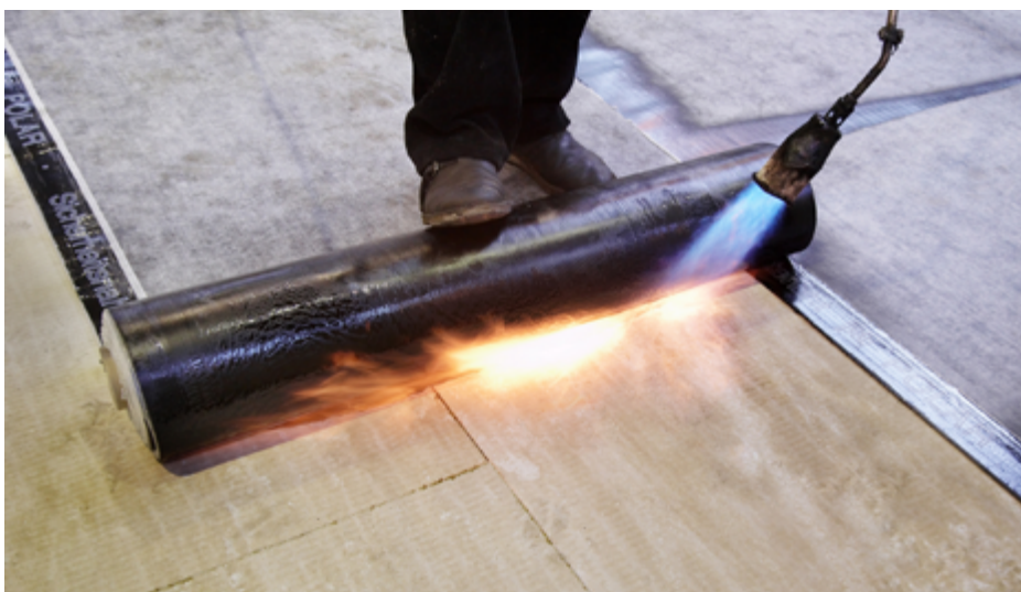
Schweißbahn auf Megarock; alle Fotos Rockwool
