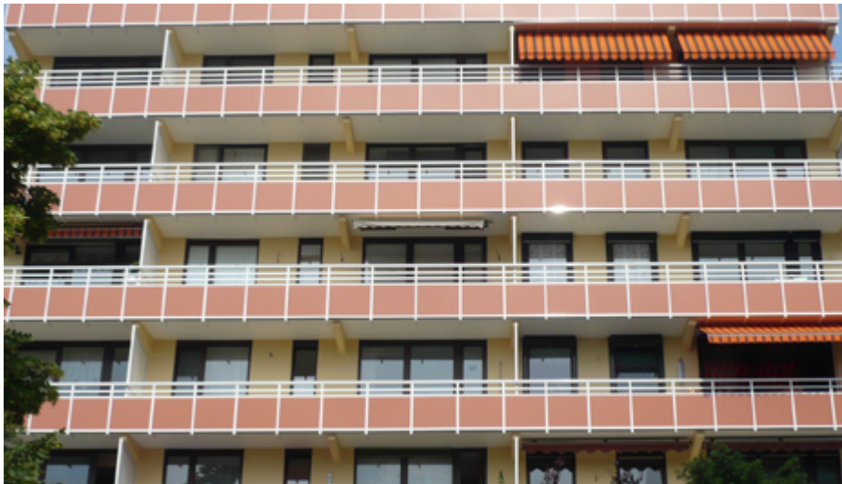
Hochhaus Ratingen; alle Foto Triflex
