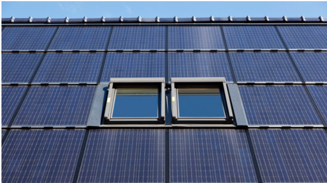
Dachfenster eingebunden; Foto Solarawatt
