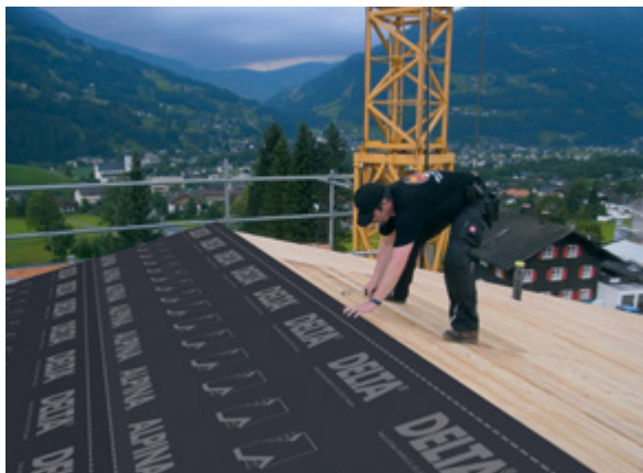
Bahnenverlegung (Dörken)
