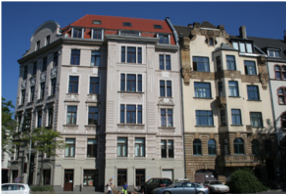
Stuckfassade saniert; Foto Krolkiewicz
