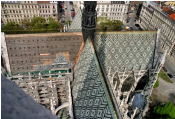
Dachsanierung Ringstrassendom Wien
