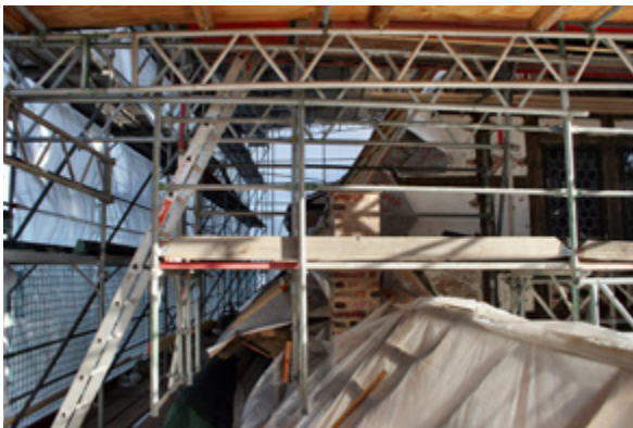
Dachsanierung unter Schutzdach
