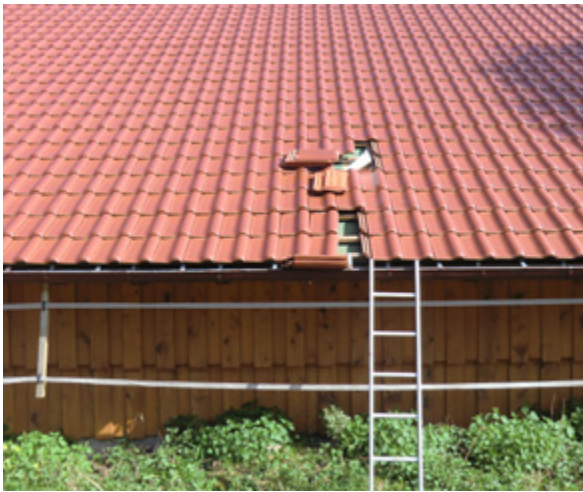
Dachprüfung ; Foto Walter
