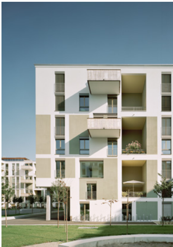
WDVS-Fassade; Foto Knauf
