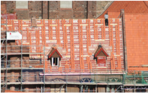
Dachsanierung Museum Stralsund
