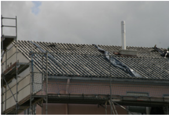
Asbestzement Wellplatten Sanierung
