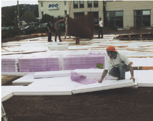
Dämmung Bodenplatte; Foto Jackodur
