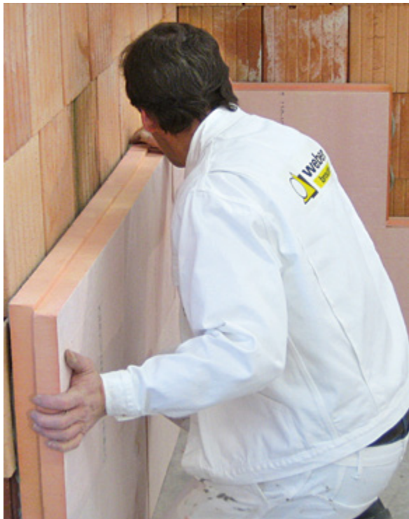
Außenwanddämmung WDVS; Foto Weber
