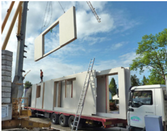
Anlieferung vorgefertigte Bauteile; alle Fotos Jarde Holzbau
