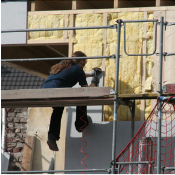
Fassadendämmung Holzunterkonstruktion
