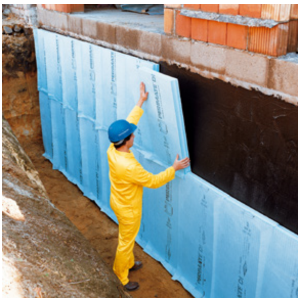
Bodendämmung Polystyrol
