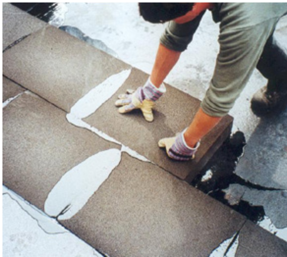
Bodendämmung Schaumglas
