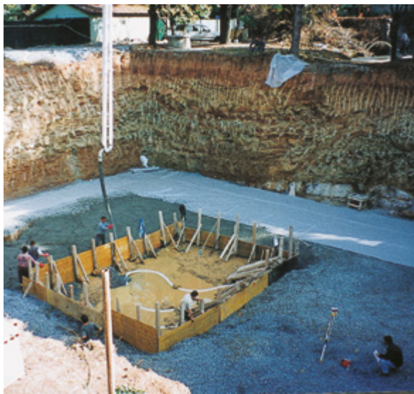
Anwendung Bodenplatte Typar; Foto DuPont de Nemours
