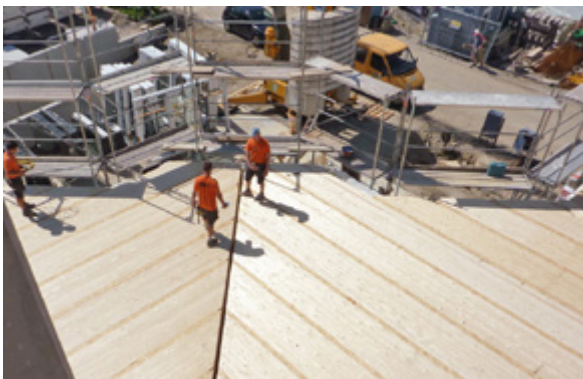
Die fertige Oberseite der Massivholzdecke
