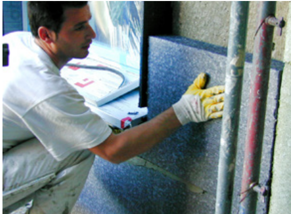
WDVS Fassadendämmung mit XPS
