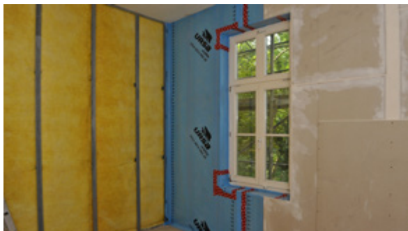
Innendämmung Wand; Foto URSA
