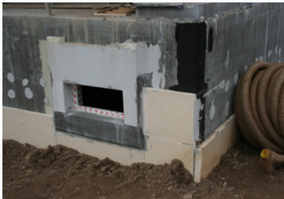
Kellerfenster Perimeterdämmung
