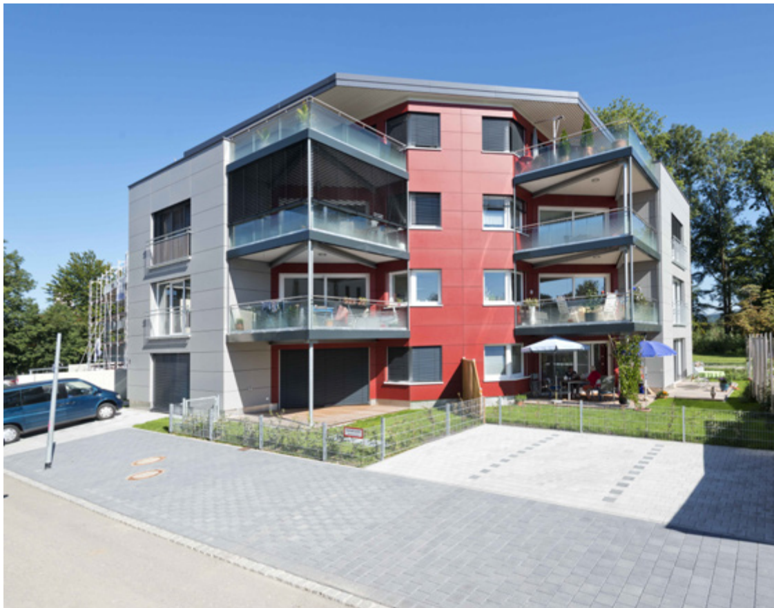
Gebäude aus Holz mehrgeschossig; Foto Jarde Holzbau
