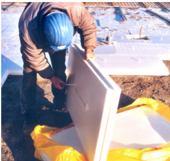
Bodendämmung Polystyrol
