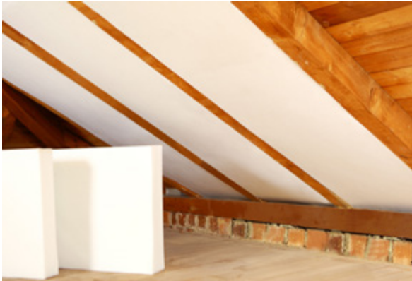
HACObond Dachstuhl; Foto Ziegler
