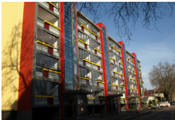
Nachträglich verglaste Balkone
