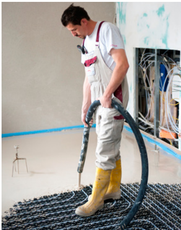
Nivellierestrich; Foto Knauf
