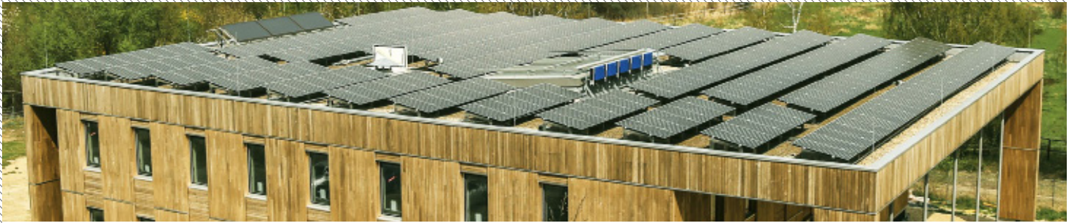
Die 281 H250 Module, die dank der speziellen HIT®-Technologie eine Moduleffizienz von 18,0% bieten; Foto Jürgen Völker/AS Solar
