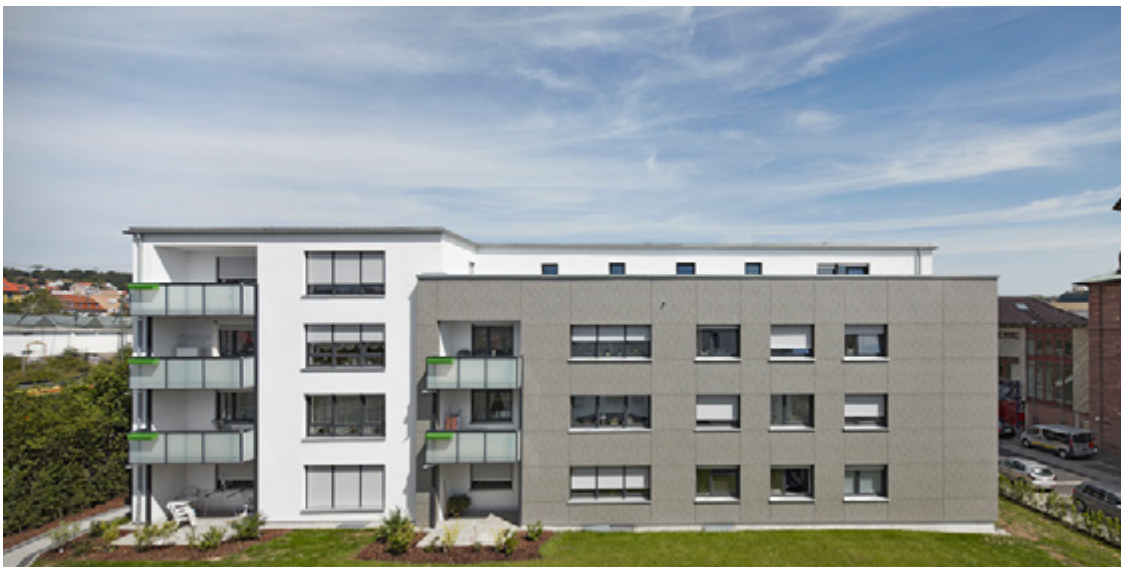
Gebäude nach Komplettsanierung; alle Fotos ARGE WoWi
