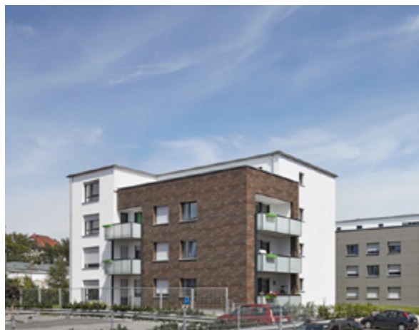
Ansicht nach Fertigstellung
