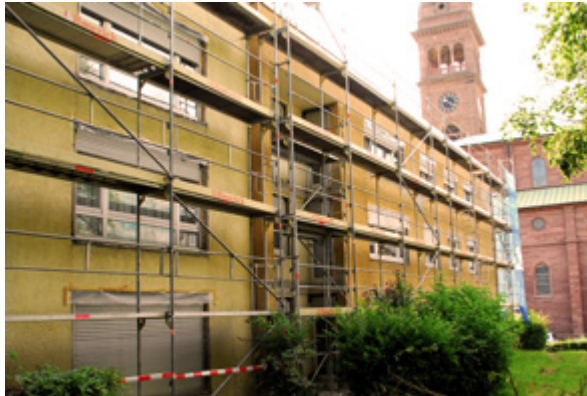
Bauzustand vor Sanierung
