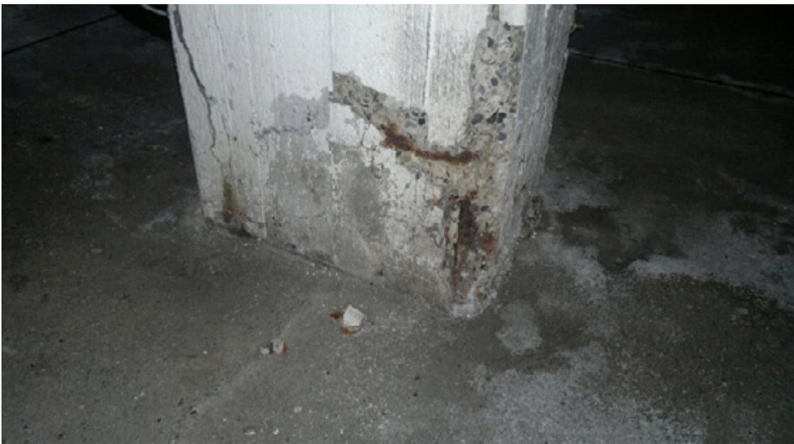
Aufsteigendes Wasser führt Schäden am Beton oder zu Korrosion an Stützen und Bewehrungen aus Metall
