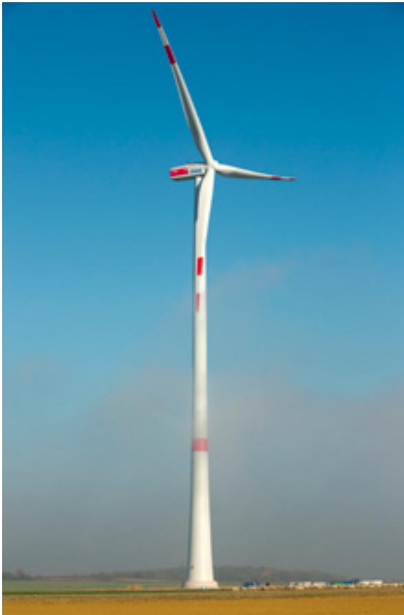
7 Megawatt und erzeugt jährlich ca. 16.000 Megawattstunden Strom, mit denen ungefähr 4.500 Haushalte mit klimafreundlicher Energie versorgt werden können. Die Windkraftanlagen gehören zu den leistungsstärksten, die zurzeit im Binnenland eingesetzt werden, und sind mit einer Nabenhöhe von 128 Metern optimal für den Einsatz zu Lande geeignet. Sie sind seit Ende 2012 in Betrieb und speisen Strom nach den Regeln des EEG in das Netz ein.
